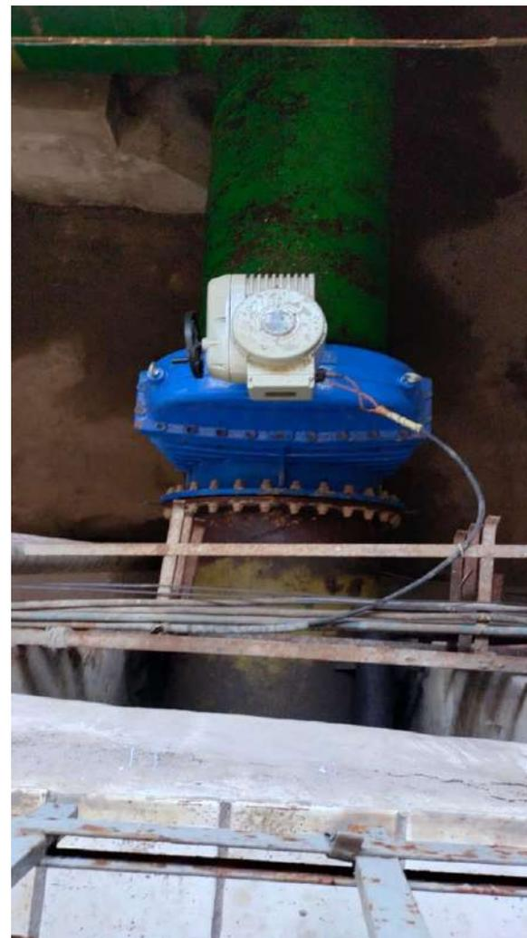
Установка запорной арматуры с электроприводом на СВиО
