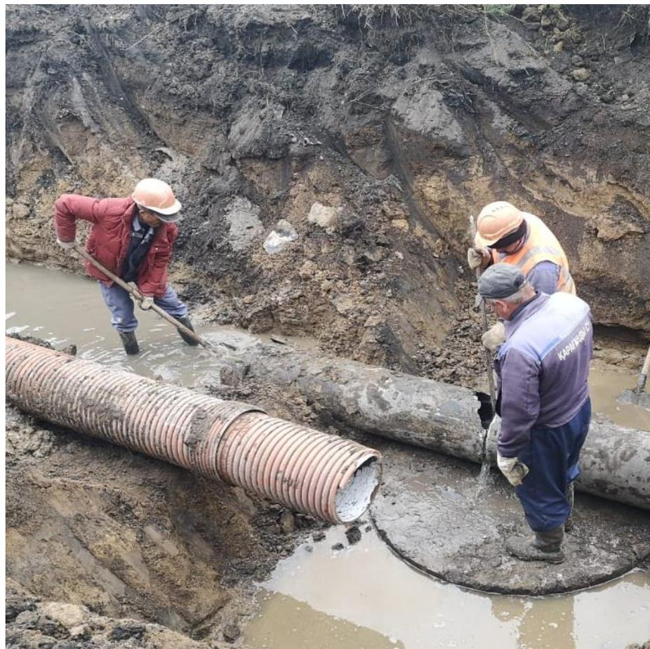
**По инвестиционной программе проведен капитальный ремонт канализационных сетей протяженностью 6,2 км. на сумму 286 млн. тенге В т.ч. бестраншейным методом заменили 2154 м. сетей (35%).**
